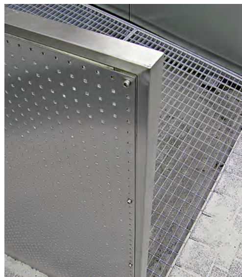
Balustrady tej niewielkiej rampy zostały wyłożone perforowaną blachą ze stali nierdzewnej o szlifowanym wykończeniu powierzchni.
