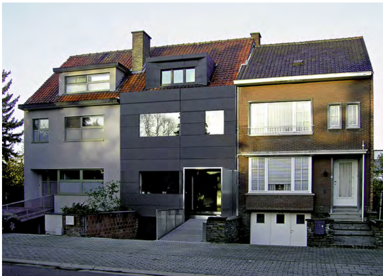
Część nowego wejścia, gdzie na betonowej elewacji zastosowano okładzinę ze stali nierdzewnej.
